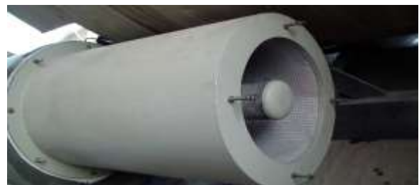
شکل ۱. نمایی واقعی از سایلنسر طراحی شده
