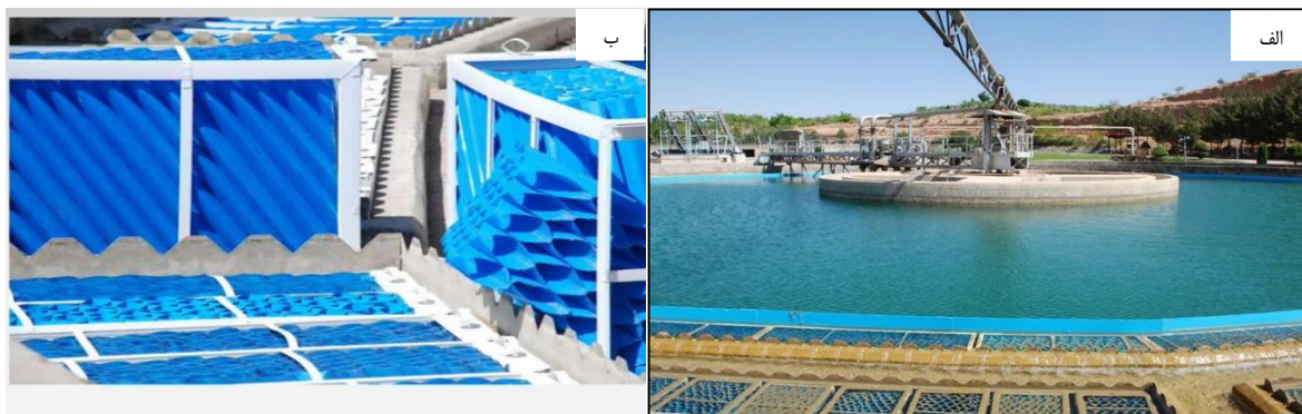
شکل ۱. نمای ته‌نشین‌کننده‌های لوله‌ای در کلاریفایرهای مورد بررسی الف. نمای ته‌نشین‌کننده‌های لوله‌ای و ب. موقعیت قرارگیری ته‌نشین‌کننده‌های لوله‌ای
