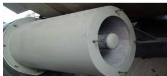
شکل ۱. نمایی واقعی از سایلنسر طراحی شده
